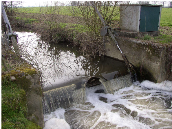
Clapet semi-automatique ou automatique à vérin
