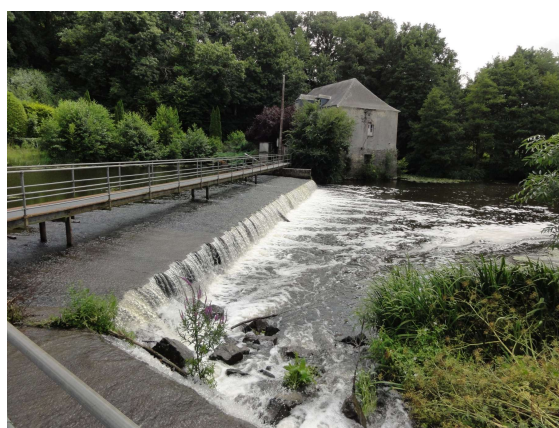
Ouvrage complexe lié à un moulin (déversoir + clapet + vanne usinière)
